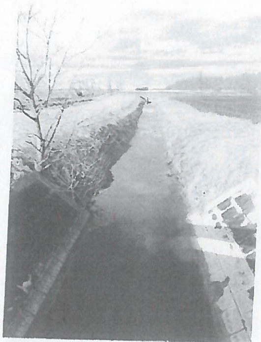
1. sz. Átvezető csatorna(4-s számú főút K-i oldala)
