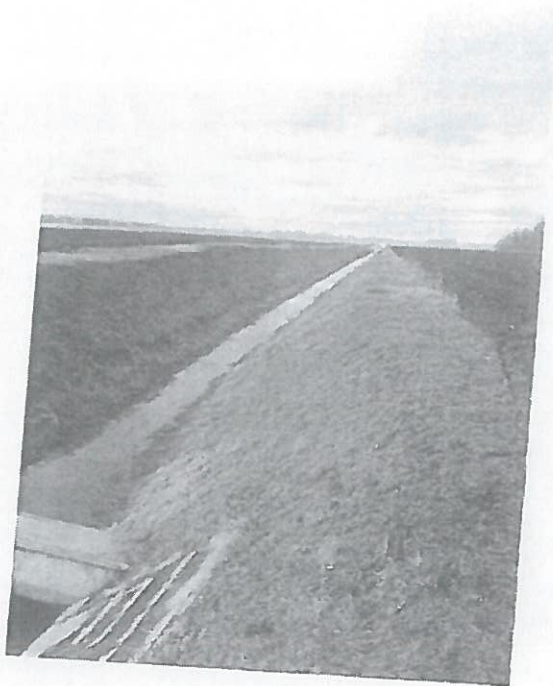
1. sz. Átvezető csatorna(4-s számú főút Ny-i oldala)
