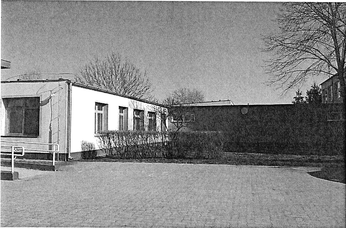
bővítmény tervezett helye – a nagykonyhára és jelenlegi folyosóra nézve
